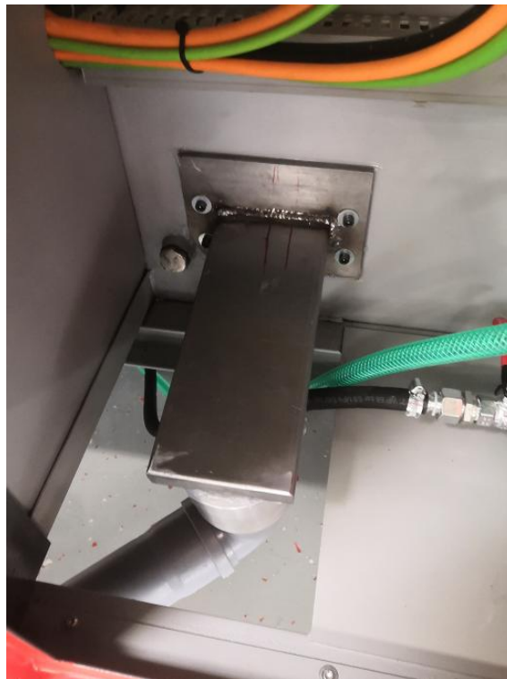
Adaptation sur évacuation, réalisation client
